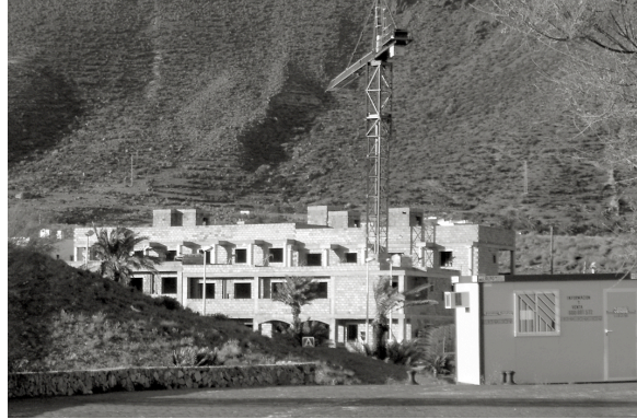
Foto núm. 4 La Isleta del Moro urbanización de 100 casas en suelo protegido
