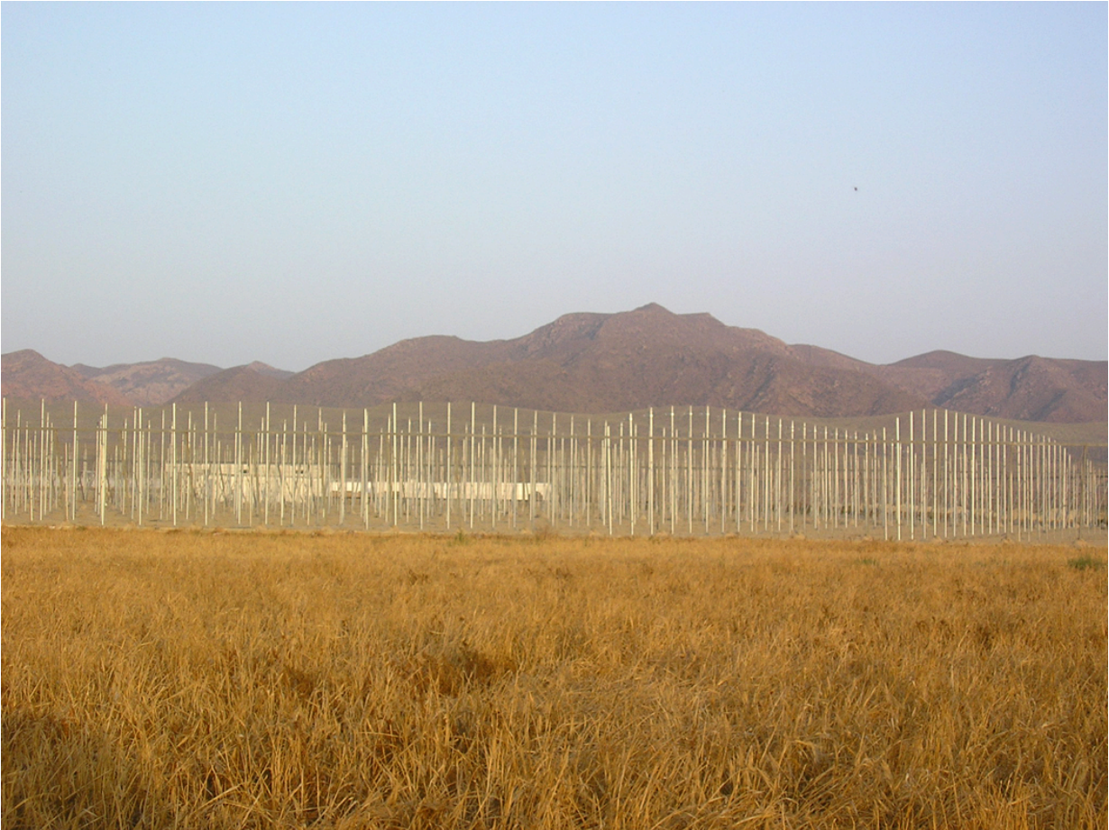
Foto núm. 8: 80 INVERNADEROS ILEGALES DENTRO DEL PARQUE NATURAL
