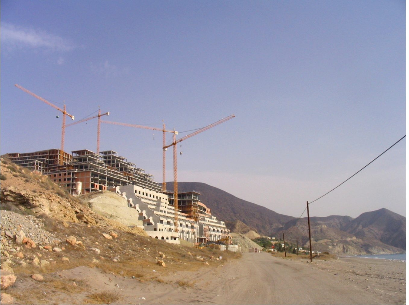
Foto núm. 2. La misma playa de El Algarrobico en plenas obras de urbanización
